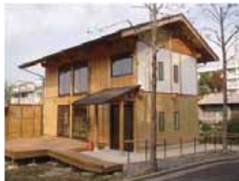
写真2 実験住宅「律周舎」
