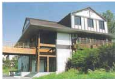
写真1 木質材料実験棟全景
