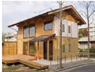
写真2 実験住宅「律周舎」
