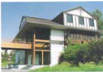
写真1 木質材料実験棟全景
