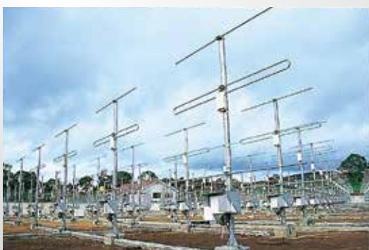
インドネシア共和国西スマトラ州の赤道直下に位置する、2000年度末に完成した大型の大気観測用レーダーです。周波数は47MHzで、八木アンテナ560本から構成される直径約110mの略円形アンテナアレイを備えています。小型の送受信モジュールが全ての八木アンテナの直下に備えられたアクティブ・フェーズド・アレー構成をとっています。MUレーダーと比べて最大送信出力が1/10であるものの、高速ビーム走査が可能です。EARはインドネシア国立研究革新庁(BRIN)との密接な連携のもとで運営されており、2001年7月から現在まで長期連続観測を続けています。
