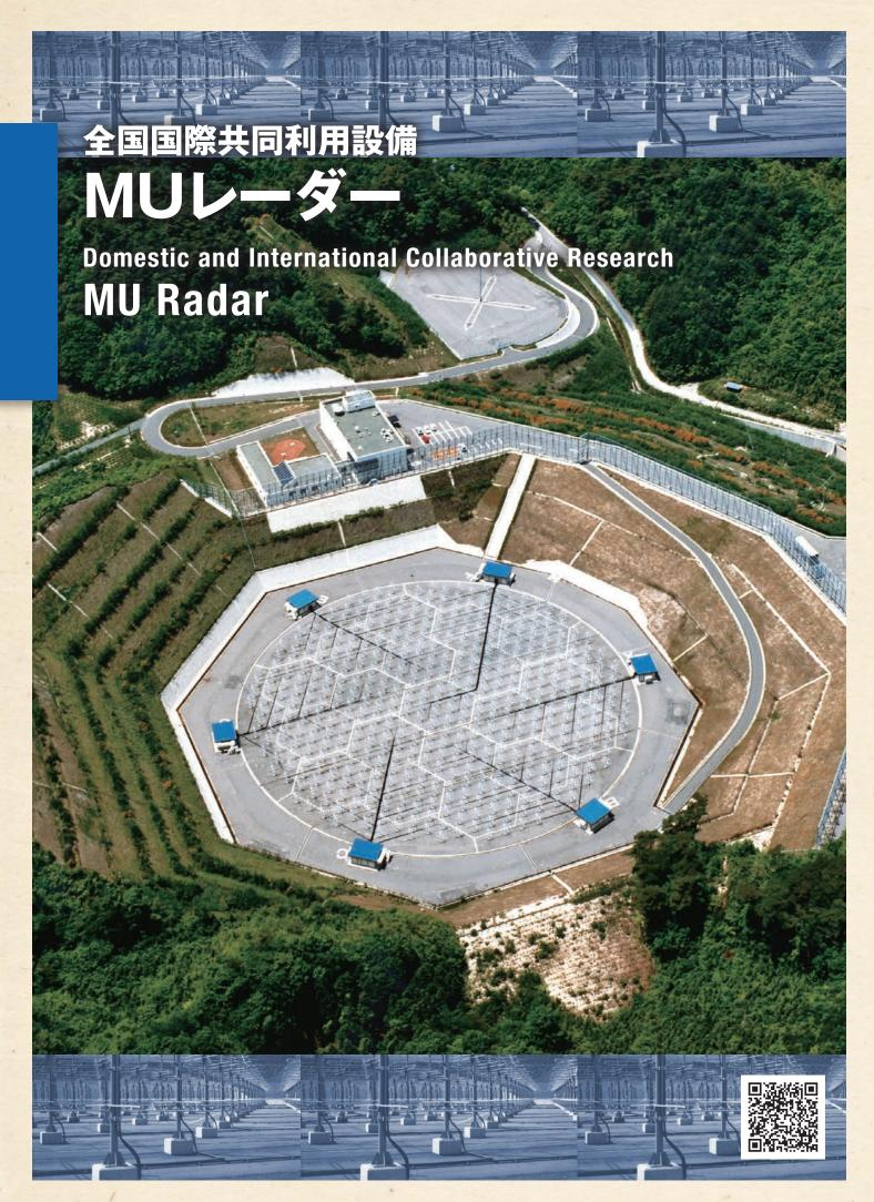
MUレーダー (Middle and Upper Atmosphere Radar: 中層超高層大気観測用大型レーダー) は、滋賀県甲賀市信楽町の信楽 MU観測所に設置された世界最高性能、アジア域最大級の規模を誇る大気観測レーダーです。1984年の完成以来、国内外の研究者に利用され、気象から超高層にいたる地球大気変動の解明に貢献しています。周波数46.5MHz、出力1MW(尖頭電力)のVHF帯電波を用い、アンテナは直径103mの円内に475本の直交八木アンテナを並べた構造です。高速な送受信ビームの制御と多種多様な観測が可能なシステム設計が特徴です。
