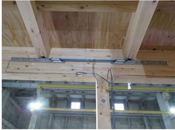
图 4.2.1-14 大梁—小梁接合部、継手接合部
