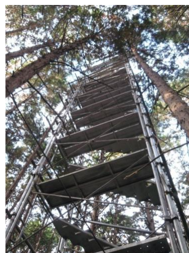
図 1：京都大学桐生水文試験地にあるフラックス観測用のタワー。地表から上空を見上げる方向の写真（筆者写真）
