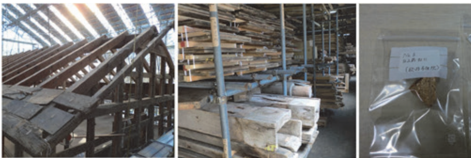
図 1：石川県にある曹洞宗大本山総持寺祖院における保存修理工事の様子（左）と再利用のために保管されている古材（中央）。建造物の文化財保存修理工事では、解体した古材それぞれについて再利用の可否を決定し保管する。このような古材の中でも再利用不可な部材では、樹種識別調査に加えて年代測定もおこなわれることがある（右）。
