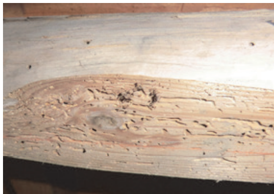
写真2：シバンムシ類による建築部材の被害（左）とヒラタキクイムシ類とナガシクイ類によるパレット材の複合被害（右）。後者では辺材のみが被害を受けているのがよくわかる。
