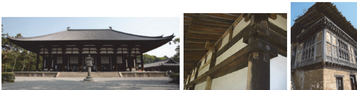
図2：深い軒(唐招提寺)、長押構造(秋篠寺)、上部土塗りと下部版築の例(Bhutan) 1)
