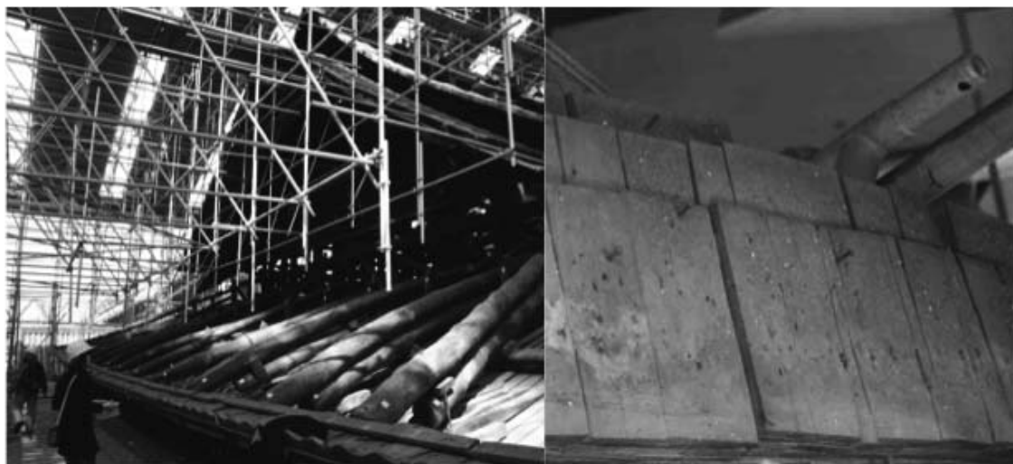
図1 知恩院集會堂修復工事の様子(左)と土居葺(右)。大屋根の土居葺は耐水性の高い樹種として現場では知られるサワラであった。造営関係文書には木曾サワラを8600丁との記述も見つかかり、当時の用材選択と木材流通を知る上で重要な知見が得られた 1) 。
