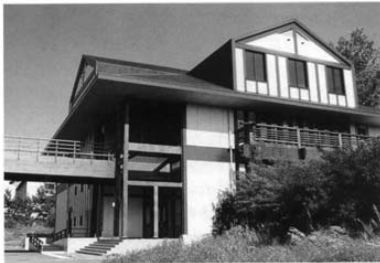
写真1 木質材料実験棟全景
