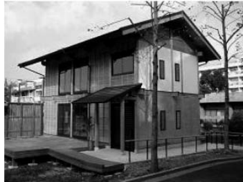
写真2 実験住宅「律周舎」
