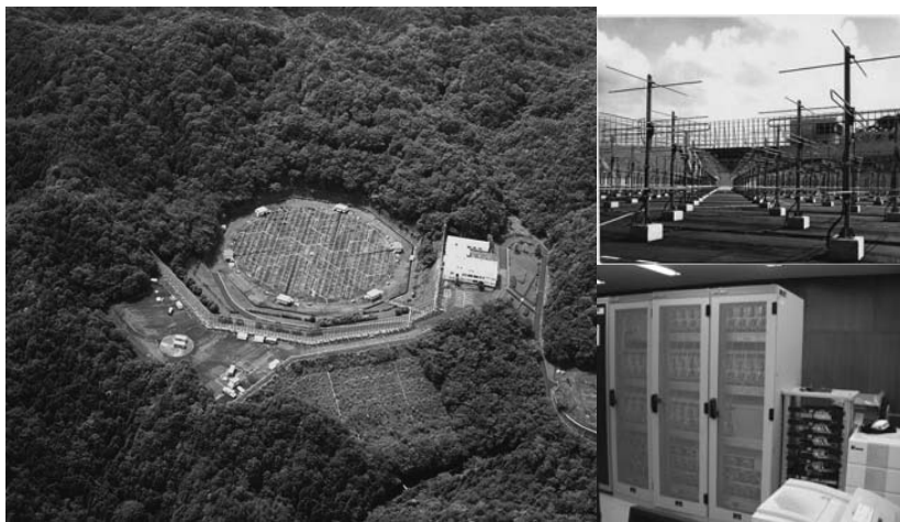
図 1: 信楽MU観測所全景 (左) と MU レーダーアンテナアレイ(右上)、MU レーダー観測強化システムで導入された超多チャンネルデジタル受信機 (右下)。
