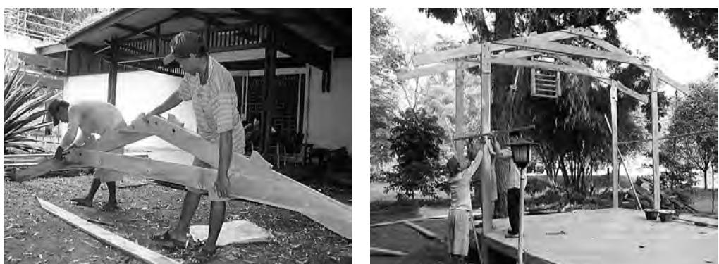
b) 骨組み架構の製造と建ち上げ
