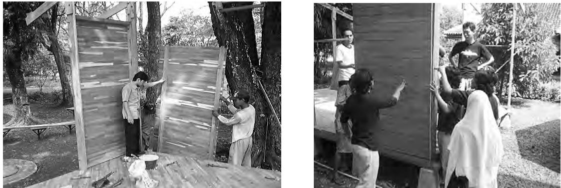
d) プレファブ生産された耐力壁ユニットの組み込み
