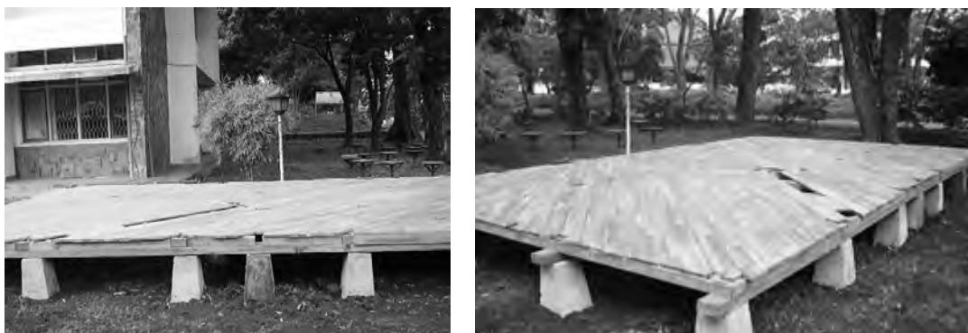
a) コンクリート製独立基礎と床構面の施工
