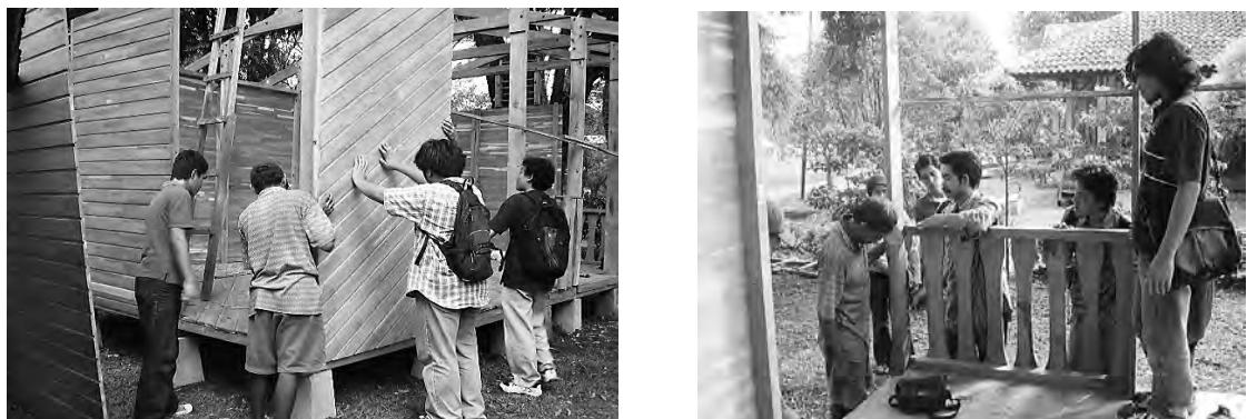
e) プレファブ耐力壁ユニットの組み込みとバルコニーの設置
