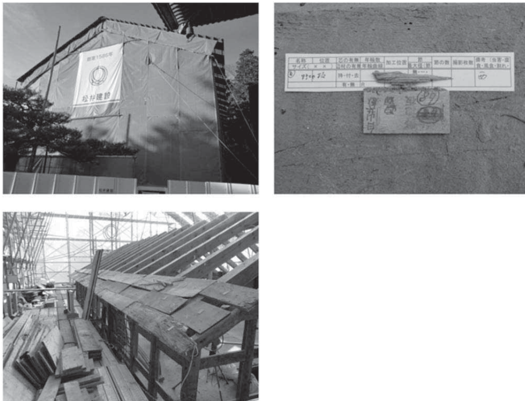
図2 修理中の総持寺祖院白山蔵（左上）、修理工事中の内部写真（左下）ならびに採取試料詳細（右上）
