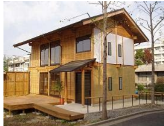
写真2 実験住宅「律周舎」
