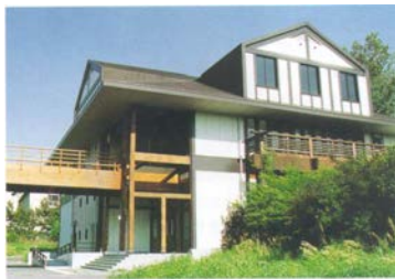
写真1 木質材料実験棟全景
