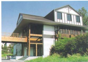
写真1 木質材料実験棟全景
