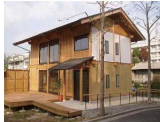
写真2 実験住宅「律周舎」
