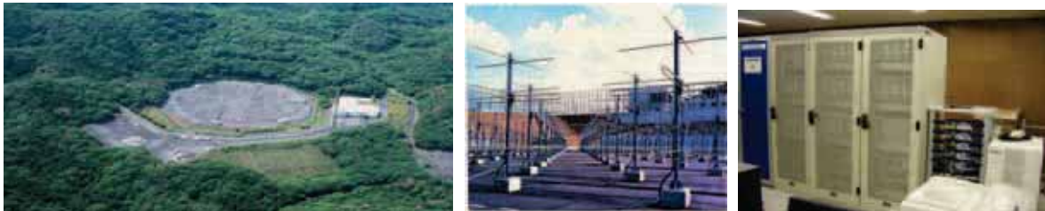
図 1: 信楽MU観測所全景（左）と MU レーダーアンテナアレイ（中）、MU レーダー観測強化システムで導入された超多チャンネルデジタル受信機（右）。
