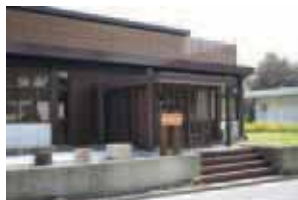
材鑑調査室工事後の外観
