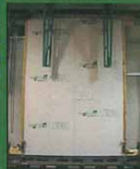
大型反力フレーム
