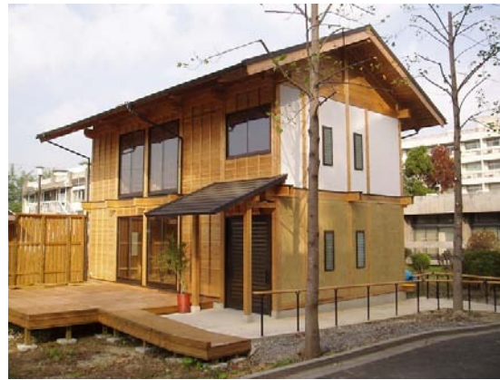
図 2.11 木造エコ住宅(律周舎)
