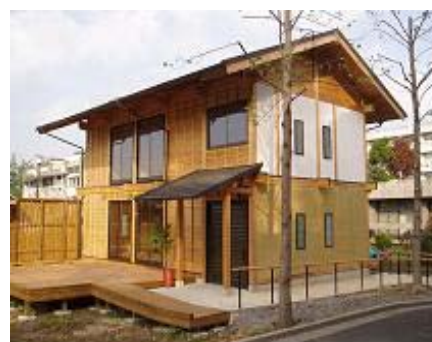
写真1 実験住宅「律周舎」
