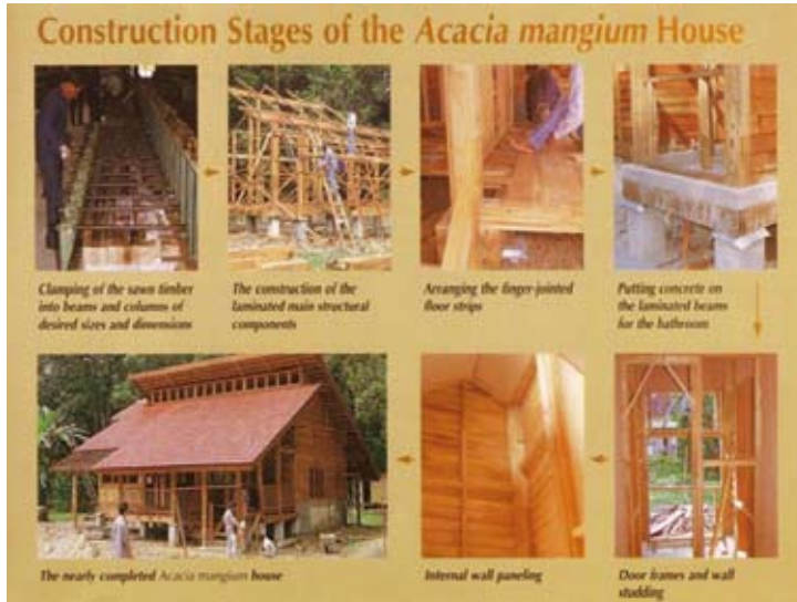
インドネシアで建築中のアカシアマンギウム実験住宅 (M. Hadi, 2006)
