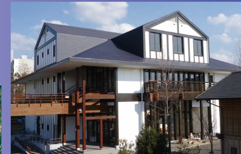
木質材料実験棟
