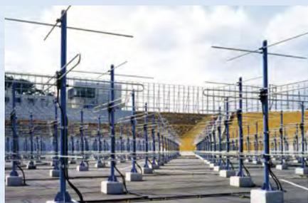
周波数46.5MHz、出力1MW(尖頭電力)のVHF帯の電波を用い、アンテナは直径103mの円内に475本の直交八木アンテナを並べた構造です。高速な送受信ビームの制御と多種多様な観測が可能なシステム設計が特徴です。2004年にMUレーダー観測強化システムを導入し、超多チャンネルデジタル受信機によるイメージング観測(大気微細構造の観測)が可能になりました。2017年にはMUレーダー高感度観測システムを導入し、受信感度が向上しています。
