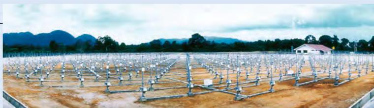
インドネシア共和国西スマトラ州の赤道にある直径110mの敷地に、560本の3素子八木アンテナを配置した大型の大気観測用ドップラーレーダーです。MUレーダーにくらべて送信出力が1/10であるものの、高速ビーム走査が可能です。高度1.5kmから20kmまでの対流圏および下部成層圏、高度90km以上に広がる電離圏イレギュラリティなど、広い高度範囲を観測できます。
