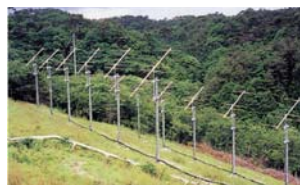
下部熱圏プロファイラレーダー Lower thermosphere profiler radar
