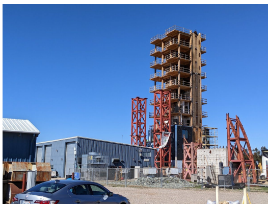
図 1 対象とした 10 階建て試験体
