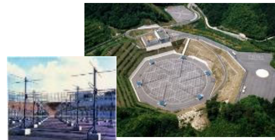
信楽MU観測所の全景。中央の円形のフィールドがMULレーダーのアンテナ(直径103m; 八木アンテナ475本)。左下:MULレーダーアンテナアレイ
