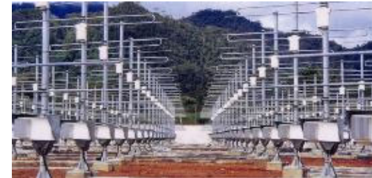
赤道大気レーダーのアンテナ (直径110m; 八木アンテナ560本)
