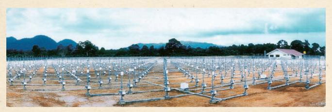
インドネシア共和国西スマトラ州の赤道直下に位置する、2000年度末に完成した大型の大気観測用レーダーです。周波数は47MHzで、560本の八木アンテナで構成する直径約110mの略円形アンテナアレイを備えています。すべての八木アンテナの直下に、小型の送受信モジュールを備えたアクティブ・フェーズド・アレイ構成で、MUレーダーとくらべて1/10の最大送信出力ではあるものの、高速ビーム走査が可能です。高度1.5kmから20kmまでの対流圏および下部成層圏、高度90km以上に拡がる電離圏イレギュラリティなど、広い高度範囲を観測できます。インドネシア航空宇宙庁(LAPAN)との協力のもとに、EARは長期連続観測を継続中です。
