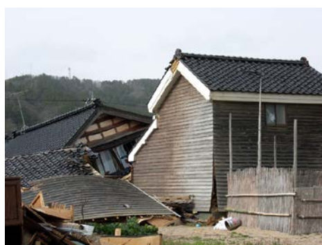
図 10：伝統木造住宅の地震被害と壁倍率の概念
