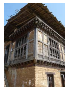
図 3：深い軒（唐招提寺）、長押構造（秋篠寺）、上部土塗りと下部版築の例（Bhutan）
