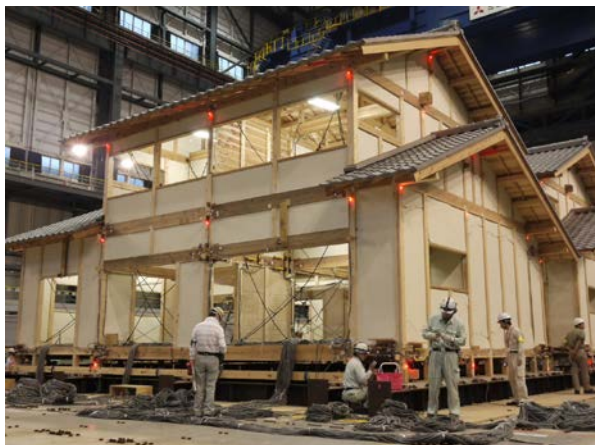
図 8：E ディフェンスにおける実大震動台試験
