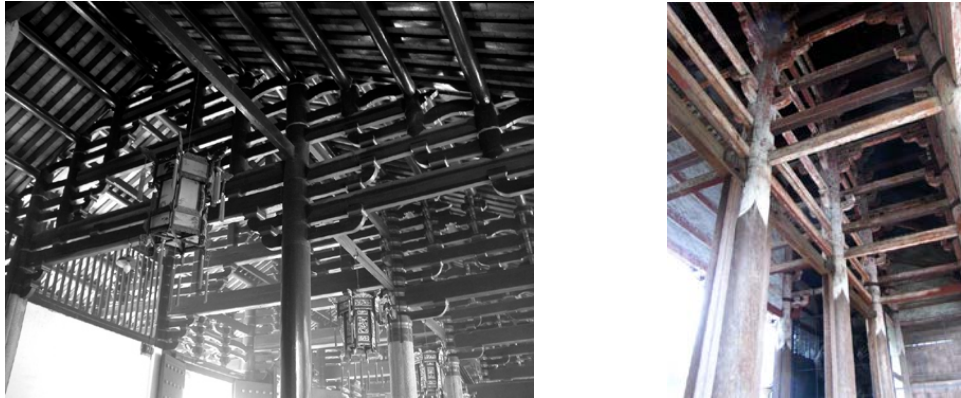
図4：大仏様の起源（左：中国潮州开元寺天王殿檐）と重源による東大寺南大門
