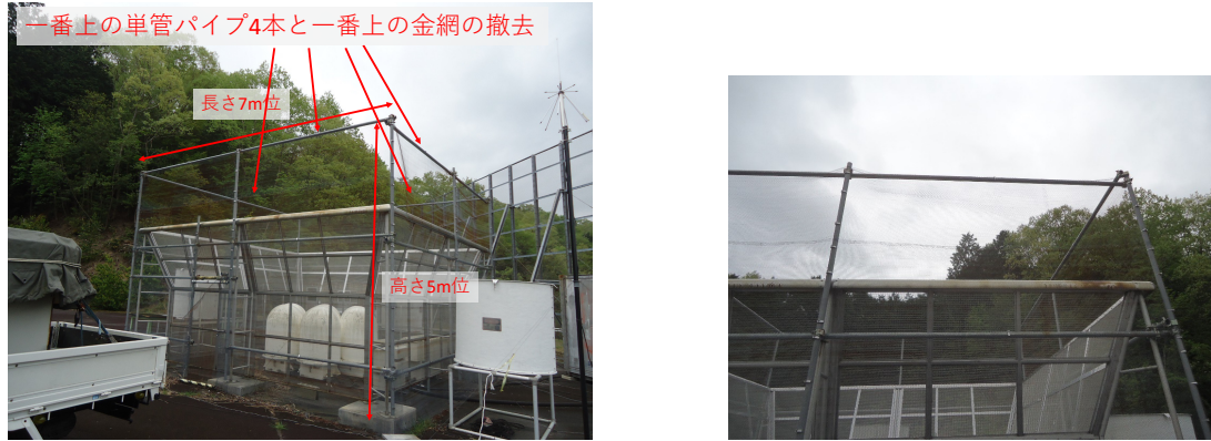
図 5: LQ-7 に設置されているクラッターフェンス
