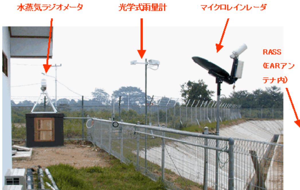
図2. 2001年度に設置された(整備中も含む)観測機器の外観と配置.
