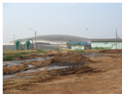
写真 6：メタン発酵装置のドーム（タピオカ抽出残渣）
