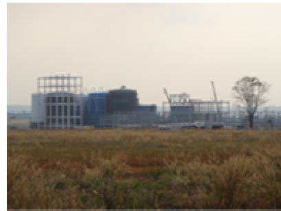
写真 1 5 建設中のバイオエタノールプラント
