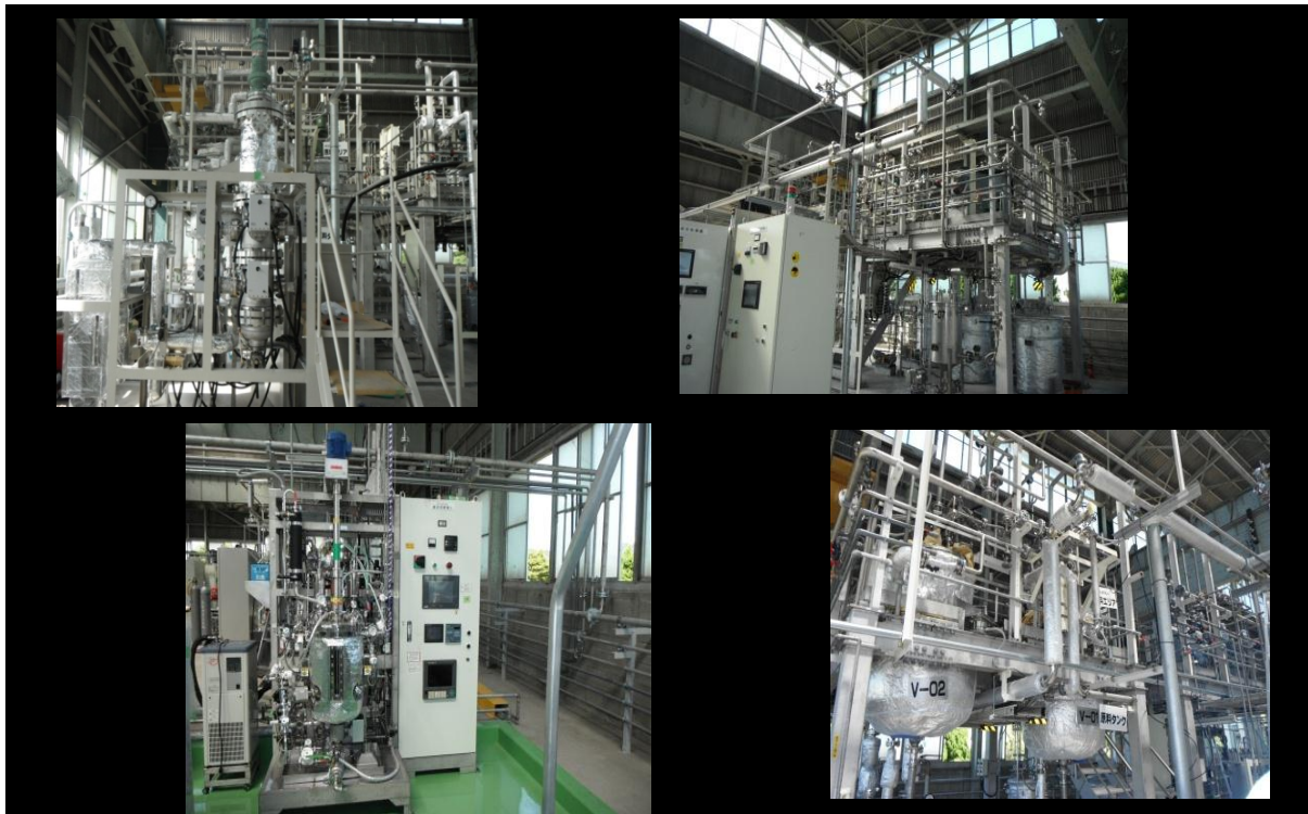
バイオエタノール生産プラント
