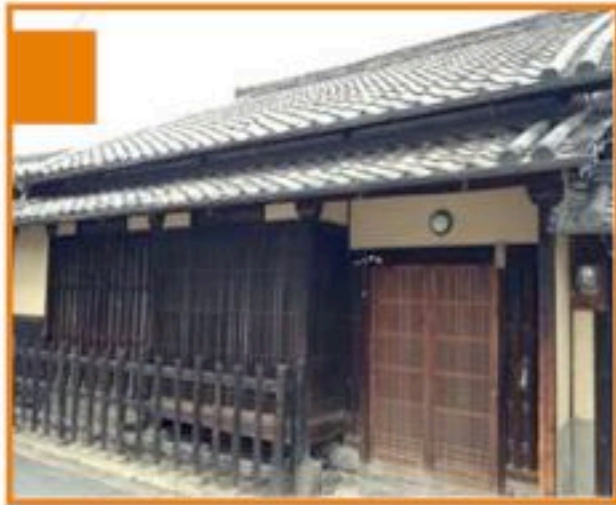
A : 昔ながらの外観 (町家、古民家、伝統工法)
