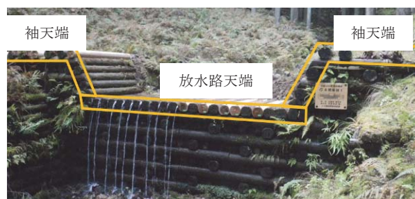
写真7 木製治山ダム
