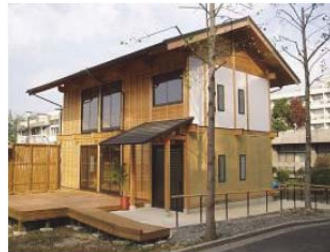
写真2 実験住宅「律周舎」
