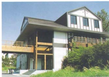
写真1 木質材料実験棟全景
