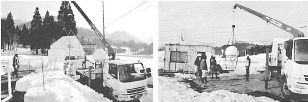
図 5. レーダ設置風景(左:FMCW 型 Ka バンドレーダ 右:X バンド天頂レーダ)
