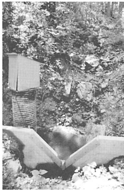
図-4 量水観測用直角三角堰 （愛媛県大洲サイト）
