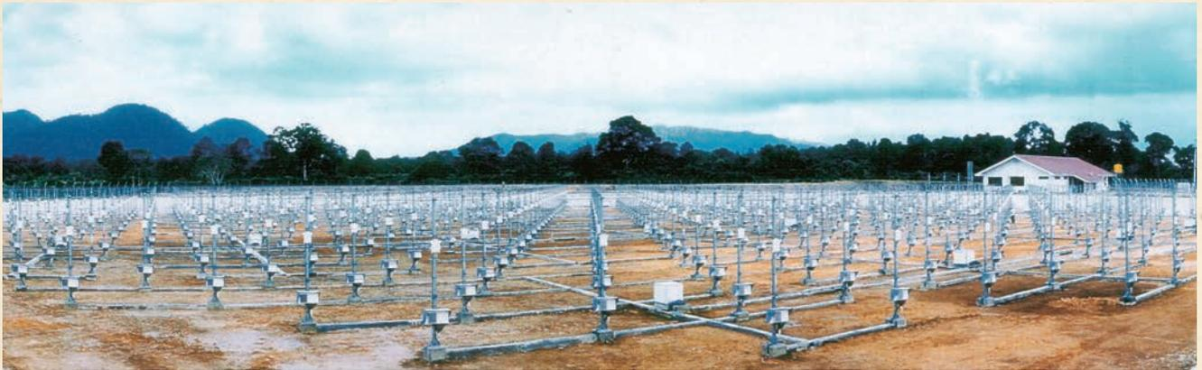
インドネシア共和国西スマトラ州の赤道直下に位置する、2000年度末に完成した大型の大気観測用レーダーです。周波数は47MHzで、560本の八木アンテナで構成する直径約110mの略円形アンテナアレイを備えています。すべての八木アンテナの直下に、小型の送受信モジュールを備えたアクティブ・フェーズド・アレイ構成で、MUレーダーとくらべて1/10の最大送信出力ではあるものの、高速ビーム走査が可能です。高度1.5kmから20kmまでの対流圏および下部成層圏、高度90km以上に広がる電離圏イレギュラリティなど、広い高度範囲を観測できます。インドネシア航空宇宙庁(LAPAN)との協力のもと、EARは長期連続観測を継続中です。
