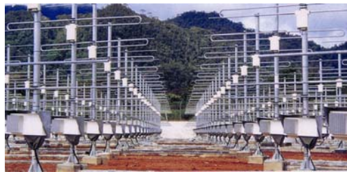
送信出力100kW, 八木アンテナ560本
