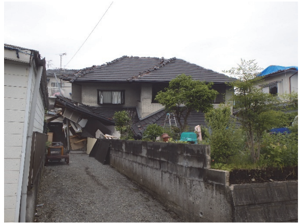
写真 6：新耐震の木造住宅の倒壊の様子 2
