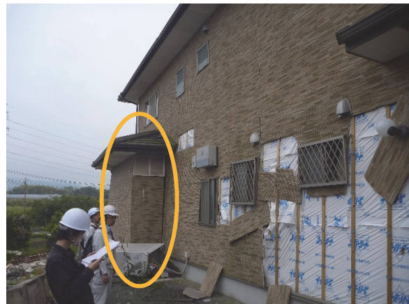
写真 13：下屋部分に耐力壁がついている様子
