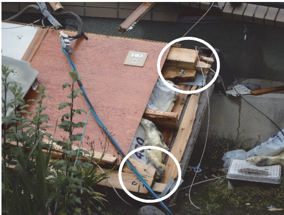
写真 7：金物が片側しか付いていない様子（上金物あり、下金物なし）
