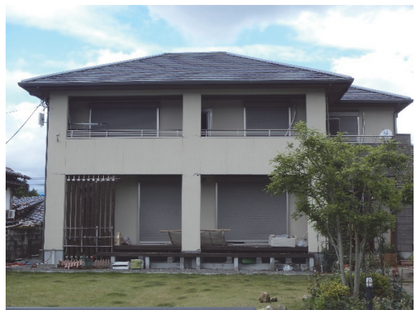
写真 9：2000年以降の軽微な損傷の木造住宅
