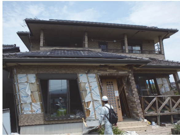
写真 11：2000 年以降の木造住宅の倒壊の様子 2
