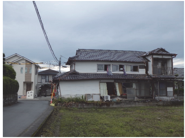
写真3：旧耐震の木造住宅の倒壊の様子2
