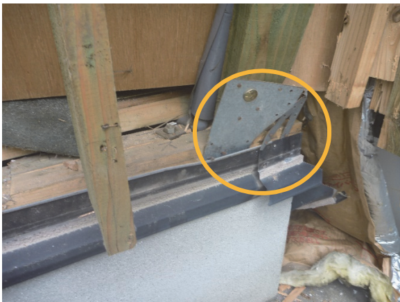
写真 12：釘の寸法が異なっている様子
