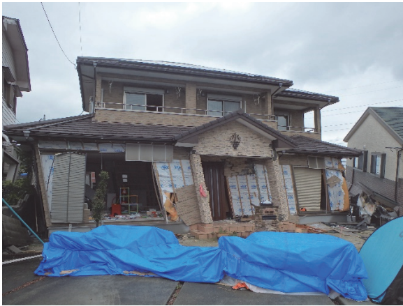
写真 10：2000 年以降の木造住宅の倒壊の様子 1
