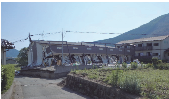
写真 16：リフォームされているが倒壊した集合住宅
