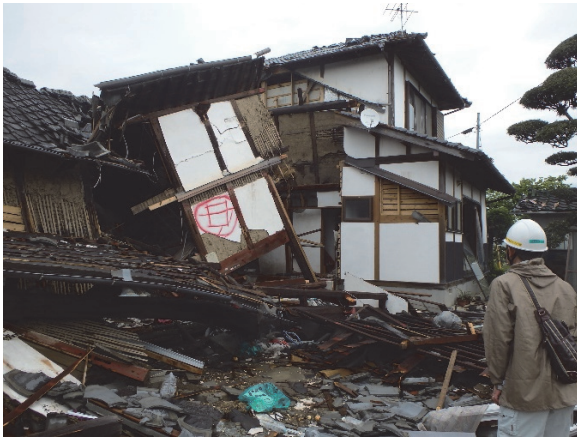
写真2：旧耐震の木造住宅の倒壊の様子1
