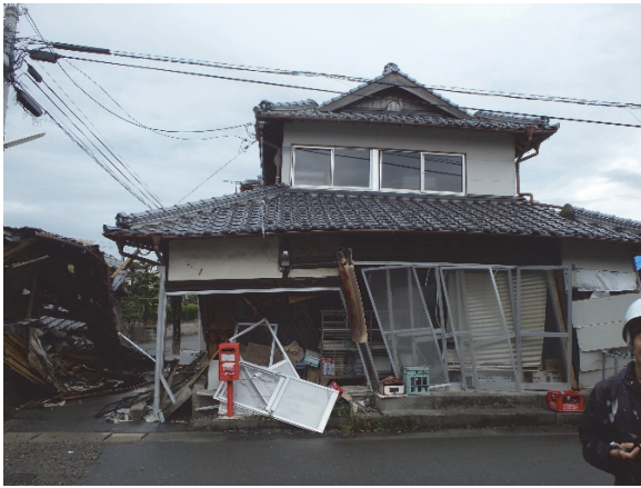
写真4：旧耐震の木造住宅の倒壊の様子3
