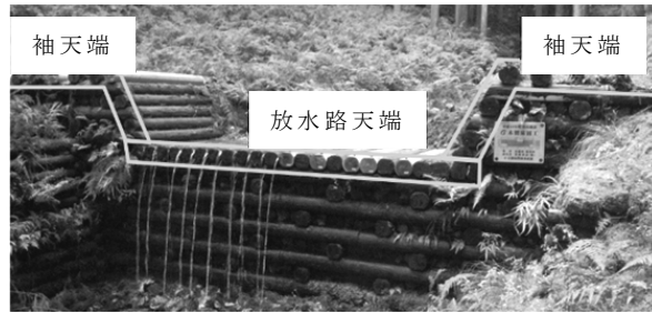
写真 7 : 木製治山ダム
