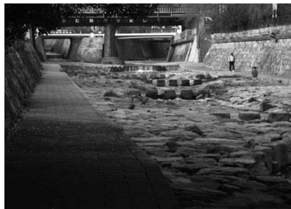
図2：都賀川の堤防内部の写真
