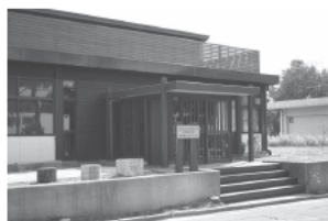
材鑑調査室工事後の外観
