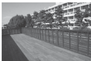
二階ウッドデッキ
