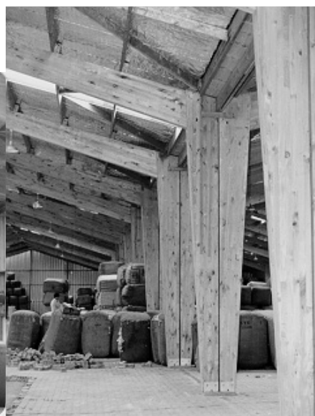
(b) 柱-梁接合部のクローズアップ
