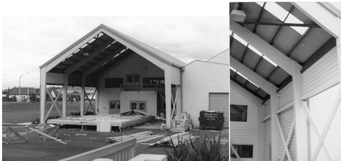
(a) 木工棟全景
