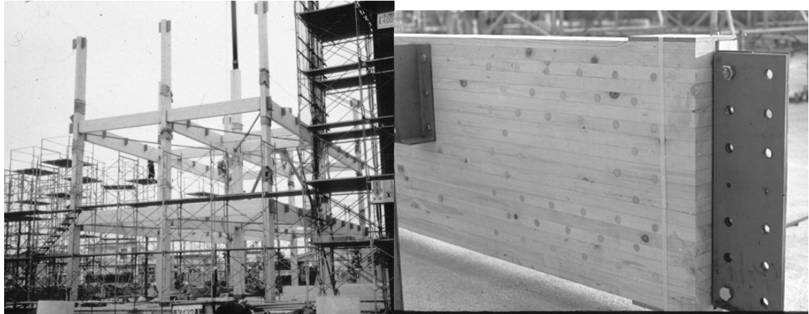
(a) 建設途中の全景
