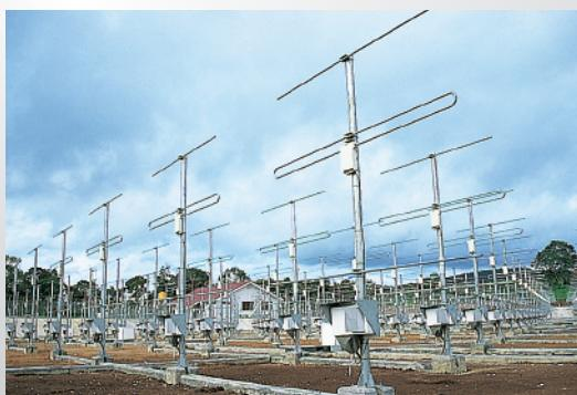
インドネシア共和国西スマトラ州の赤道直下に位置する、2000年度末に完成した大型の大気観測用レーダーです。周波数は47MHzで、八木アンテナ560本から構成される直径約110 mの略円形アンテナアレイを備えています。小型の送受信モジュールが全ての八木アンテナの直下に備えられたアクティブ・フェーズド・アレー構成をとっています。MUレーダーと比べて最大送信出力が1/10であるものの、高速ビーム走査が可能です。EARはインドネシア航空宇宙庁(LAPAN)との密接な連携のもとで運営されており、2001年7月から現在まで長期連続観測を続けています。
