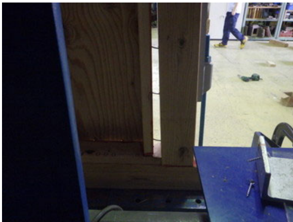
受材の浮き (裏面)
