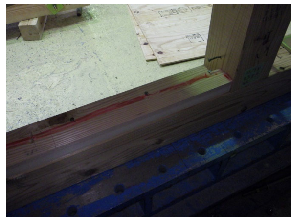
受材の割れの状況（土台側）
