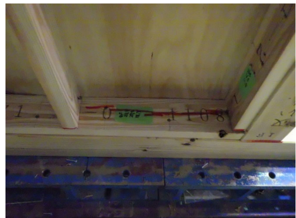
土台と受材の変形
