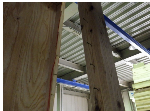
受材の割れの状況（柱側）
