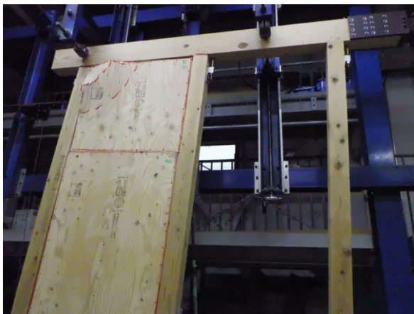
桁側、面材同士の状況
