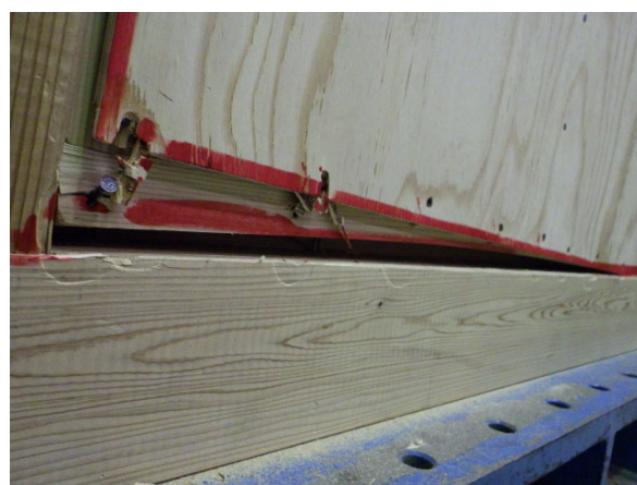
土台側受材の状況
