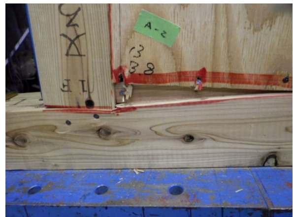
面材土台側の変形
