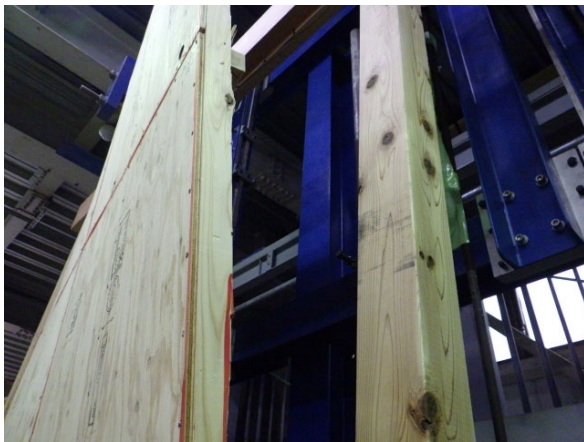
受材の割れ（柱側）（例：A-5-2）
