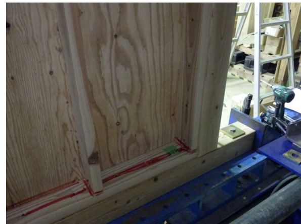
受材の割れの状況（土台側）
