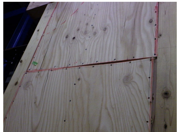
面材と面材の接触
