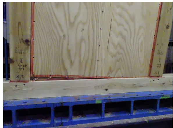
土台側の状況
