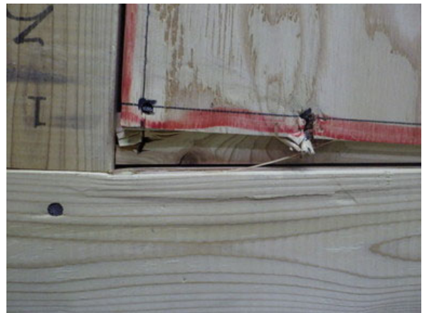
面材くぎの引き抜け（例：A-1-2 1/15rad 時）
