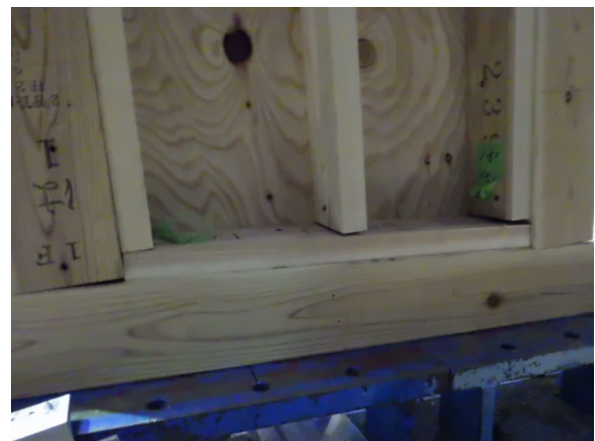
受材・間柱の浮き
