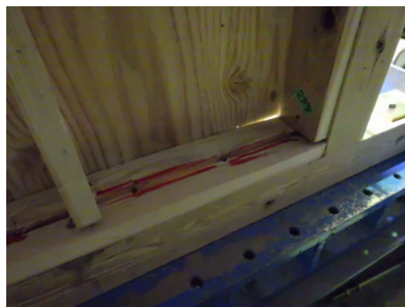
土台側受材の割れ
