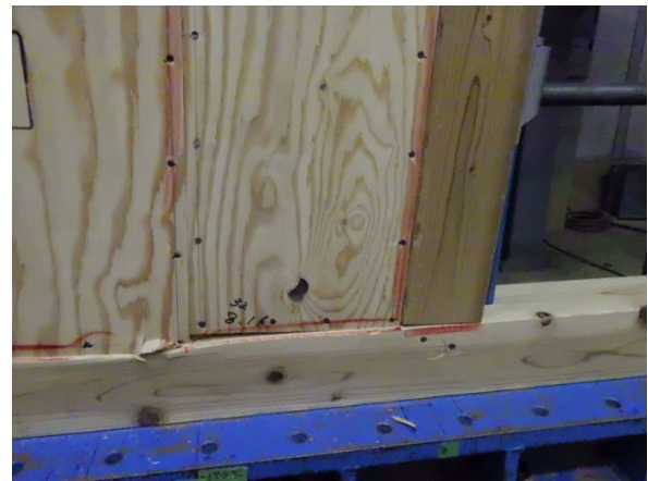
土台側の状況
