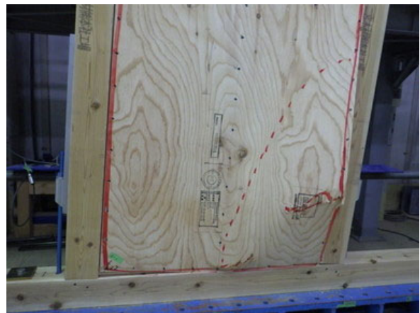
土台側の状況
