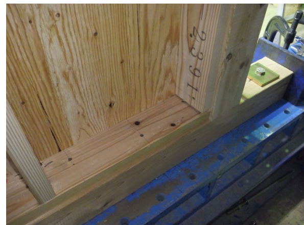
受材の状況 (割れなし)
