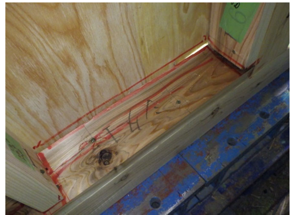
土台側受材の割れ
