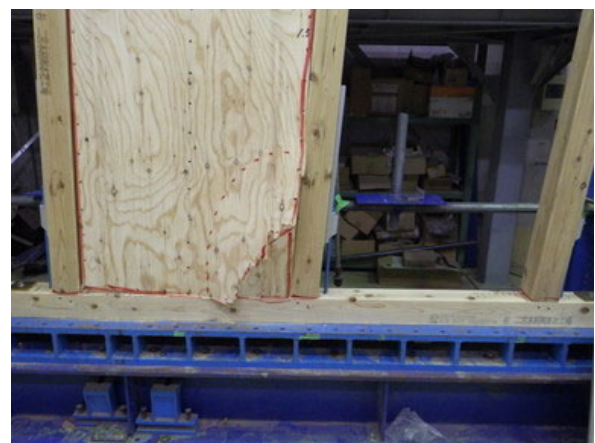
土台側の状況
