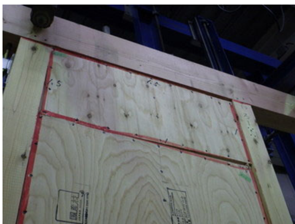
桁側、面材同士の状況
