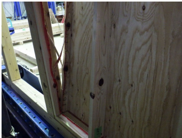
受材の割れの状況（土台側）
