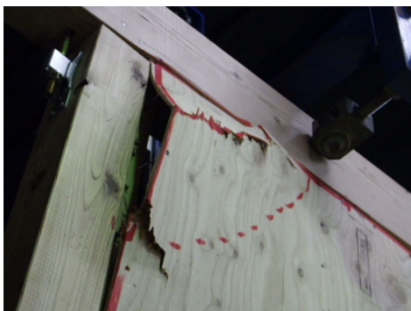
桁側面材の状況
