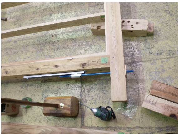
土台側ホールダウン金物の取付
