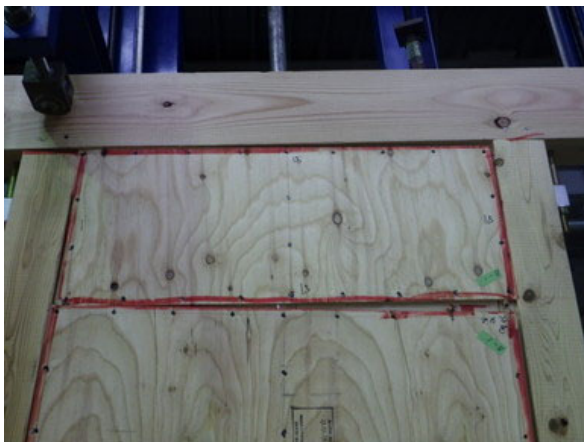
桁側、面材同士の状況
