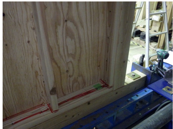
受材の割れ（土台側）（例：A-5-2）
