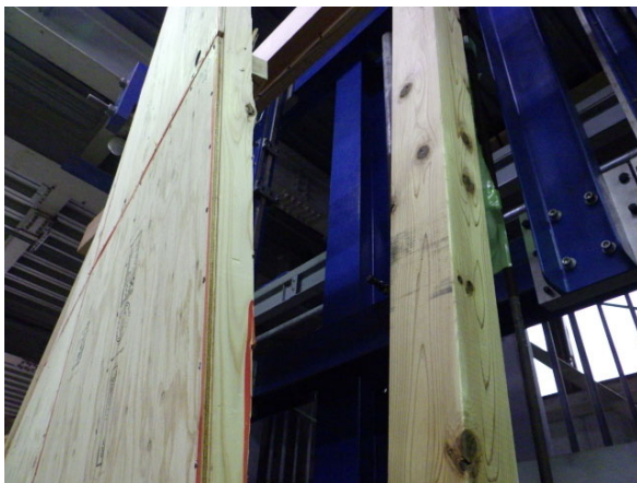
受材の割れの状況（柱側 表）
