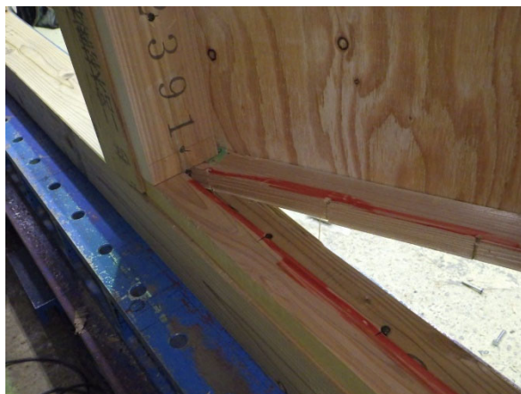
受材の割れの状況（土台側）
