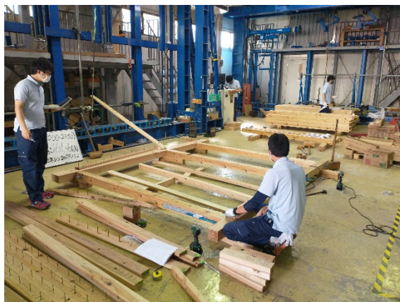
フレームの施工
