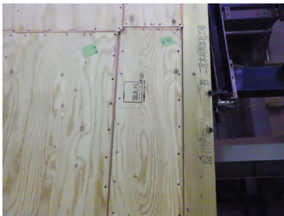
面材と面材の接触
