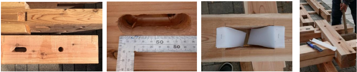
写真 3.2.1-1 ピンフレームの接合部詳細（長穴、テフロンシート挿入）
