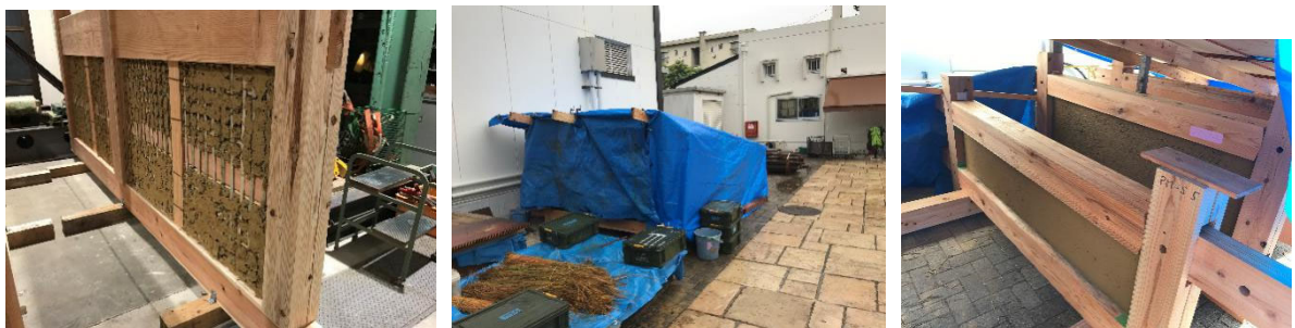
写真 3.2.1-3 試験体設置の様子
