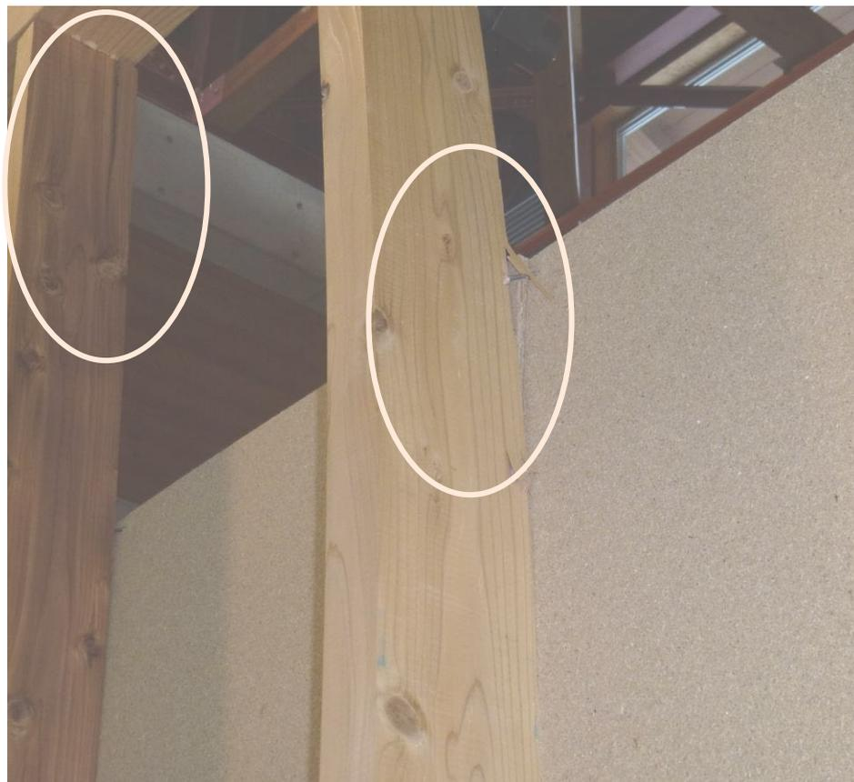
繊維傾斜がある間柱の端部に割れが生じている。
