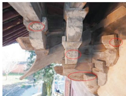
図4-2：中国伝統建物斗拱部材の欠点探査
