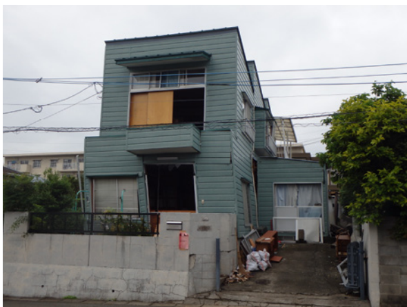
写真5 新耐震の木造住宅の倒壊の様子1
