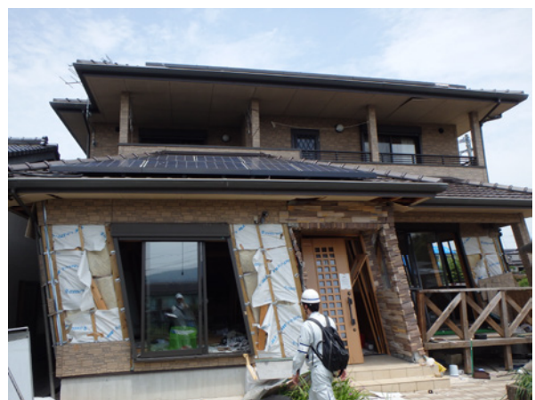
写真11 2000年以降の木造住宅の倒壊の様子2
