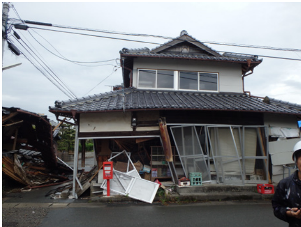
写真4 旧耐震の木造住宅の倒壊の様子3
