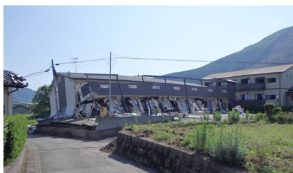
写真 16 リフォームされているが倒壊した集合住宅
