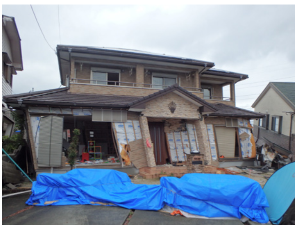
写真10 2000年以降の木造住宅の倒壊の様子1
