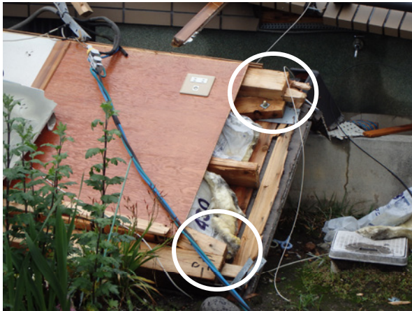
写真7 金物が片側しか付いていない様子
