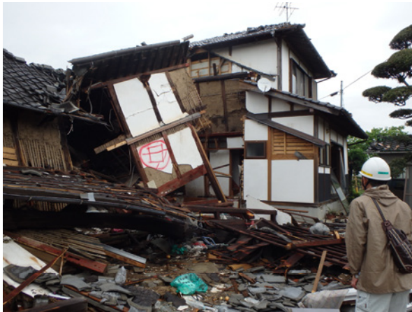
写真2 旧耐震の木造住宅の倒壊の様子1
