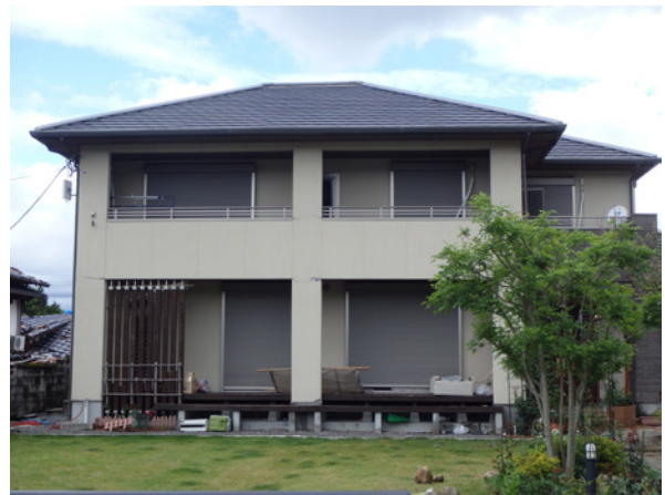
写真9 2000年以降の軽微な損傷の木造住宅
