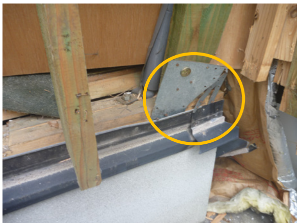
写真12 釘の寸法が異なっている様子
