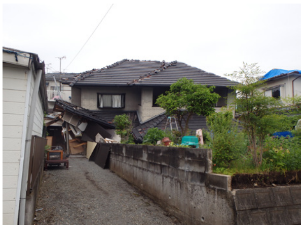
写真6 新耐震の木造住宅の倒壊の様子2
