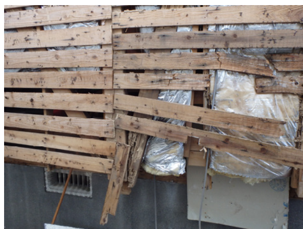
写真15 筋かい付近のシロアリの食害による筋かいの脱落
