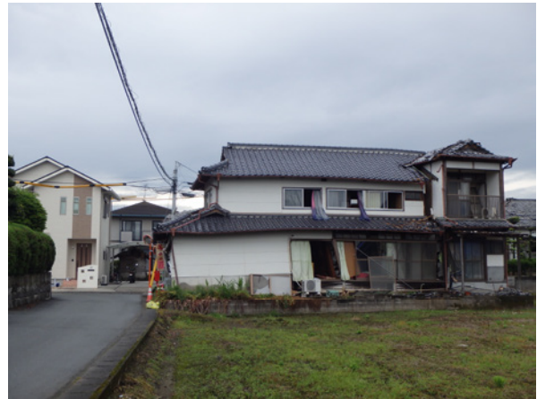
写真3 旧耐震の木造住宅の倒壊の様子2
