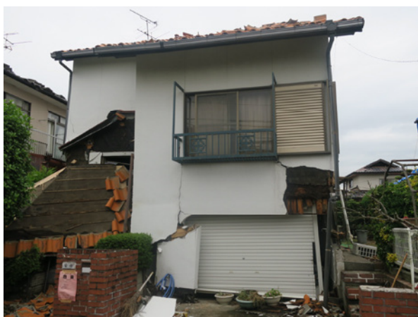
写真14 柱と土台の生物劣化による踏み外しのための大きな変形
