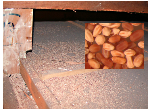
写真7：アメリカカンザイシロアリ被害家屋の屋根裏の様子。特徴的な形のフンが被害材より落下・堆積している。
