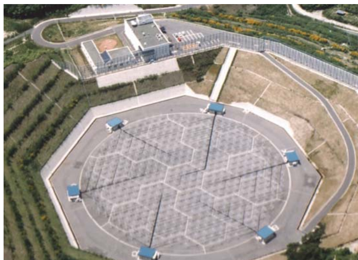
MU レーダー：中央の円形の部分が 475 本の八木アンテナから構成されるフェーズド・アレイ・アンテナ（直径 103 m）
