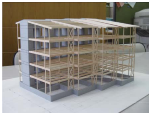
図 6-12：RC造と木造を組み合わせた構造
