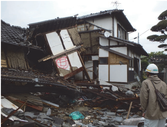
写真2：旧耐震の木造住宅の倒壊の様子1
