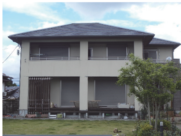
写真 9 : 2000年以降の軽微な損傷の木造住宅
