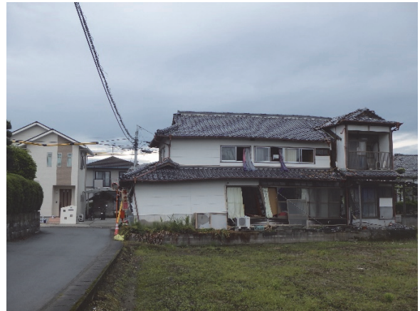
写真3：旧耐震の木造住宅の倒壊の様子2
