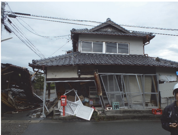
写真4：旧耐震の木造住宅の倒壊の様子3
