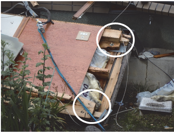
写真 7 : 金物が片側しか付いていない様子 (上金物あり、下金物なし)
