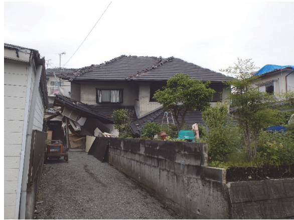
写真 6 : 新耐震の木造住宅の倒壊の様子 2
