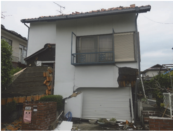
写真 14：柱と土台の生物劣化による踏み外しによる大きな変形
