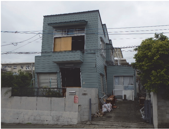
写真 5 : 新耐震の木造住宅の倒壊の様子 1
