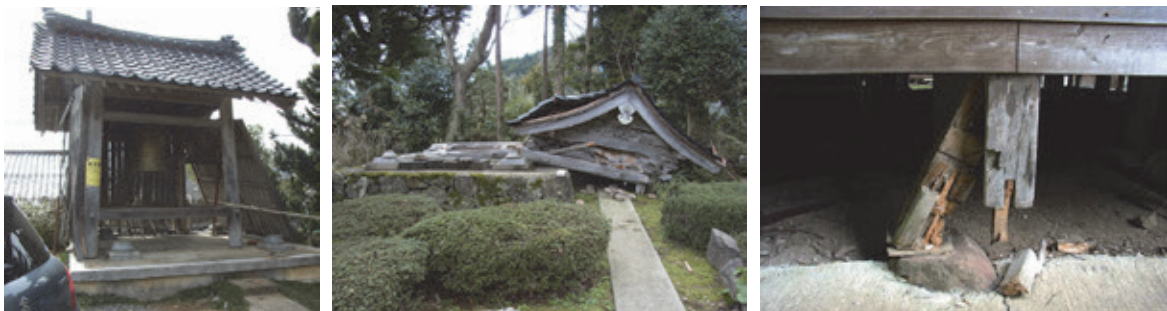
図6：地震被害の例
