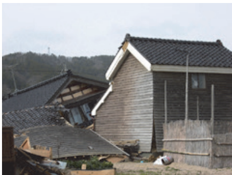
図9：伝統木造住宅の地震被害と壁倍率の概念
