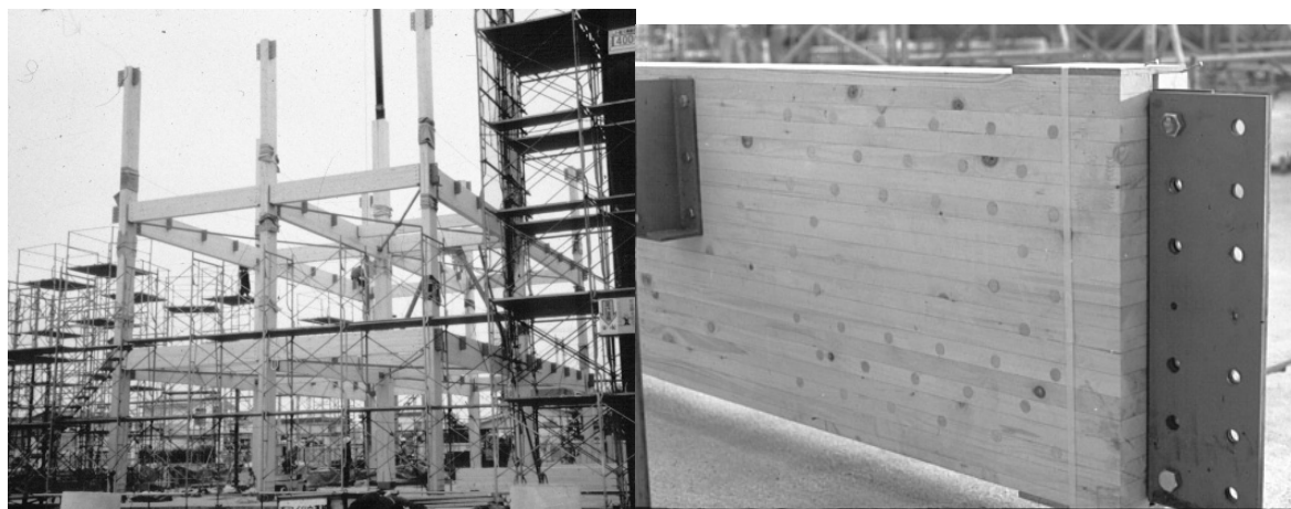
(a) 建設途中の全景
