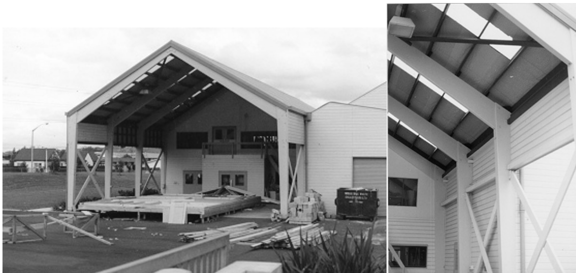
(a) 木工棟全景
