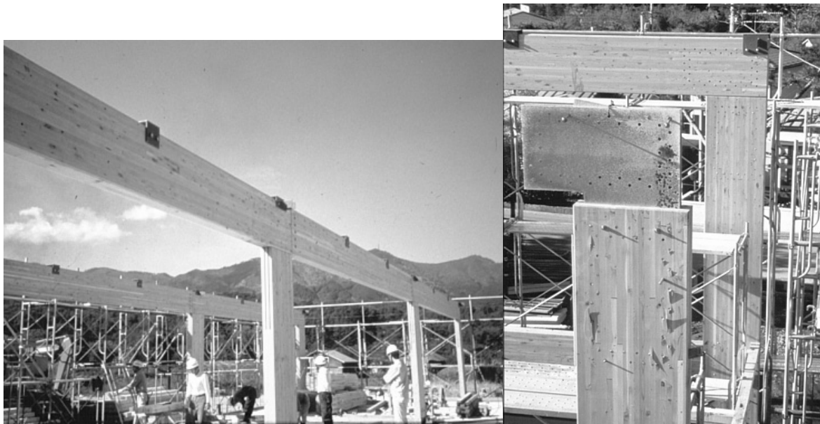
(a) 建設途中の全景
