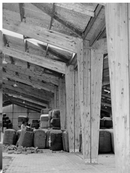
(b) 柱-梁接合部のクローズアップ
