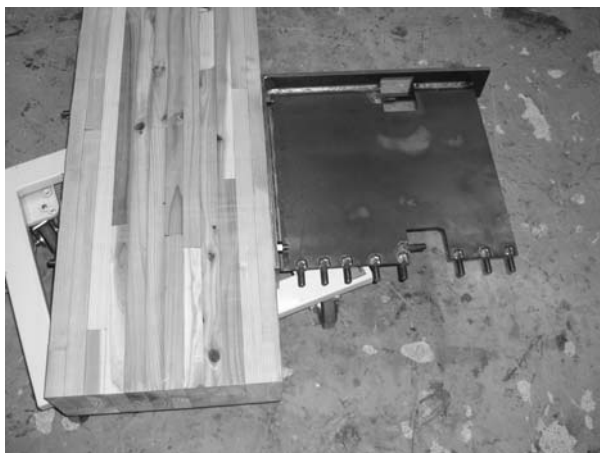
(a) 柱-梁接合部の取り付け状況
