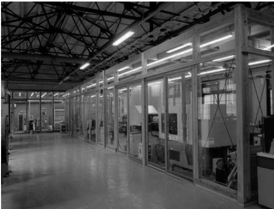
京大大学生存圏研究所のテストプラント
