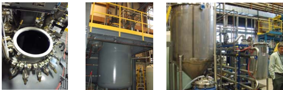
耐酸仕様(グラスライニング)パイロットプラント
